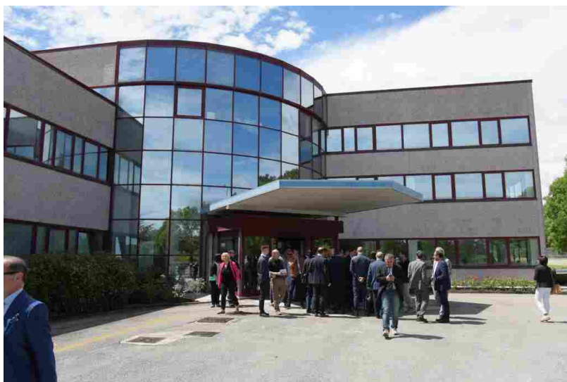
La sede centrale del Gruppo Perialisi a Jesi
